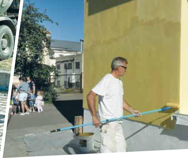
I lavori all'Asilo Sorriso di Rossosch.
